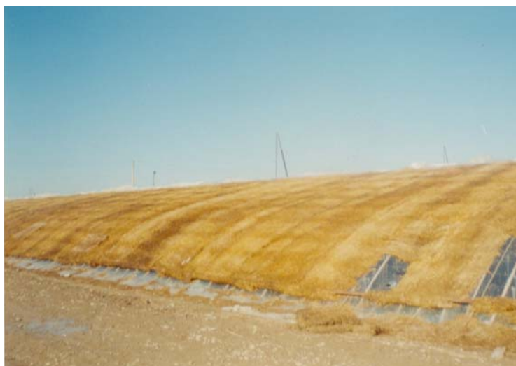
Рис. 15. Фрагмент каркаса пленочной необогреваемой китайской теплицы.
