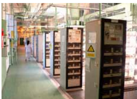
Блоки для испытания устройств освещения
