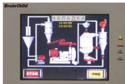
Рис. 2. Панель управления ГТЛ-304К
