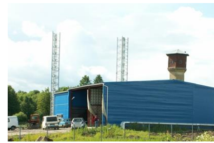
Новая котельная на фрезерном торфе
