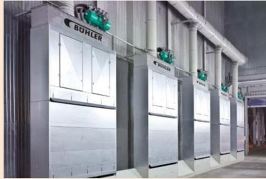
Аспирация на приемке зерна на элеваторе / ХПП
